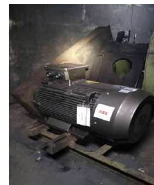
APL冷卻段噴射冷卻風扇 更換高效率馬達
