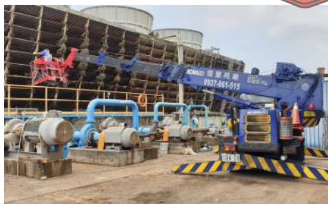
高架作業防護
