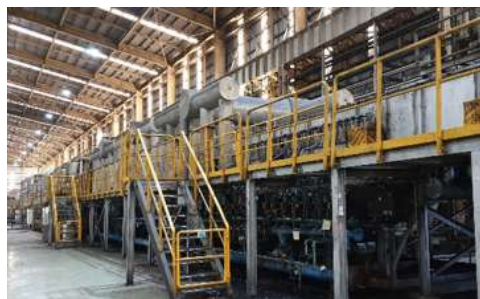
退火爐防墜欄杆
